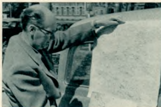
Gravimetern måste ständigt justeras med ledning av de redan existerande tyngdkraftspunkterna och här pekar hr Bilius ut den aktuella pricken på grunden till kyrkan i Landskrona, där också högkvarteret slagits upp.
